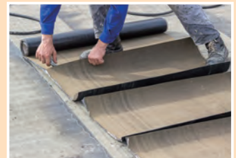
防水工事 など
